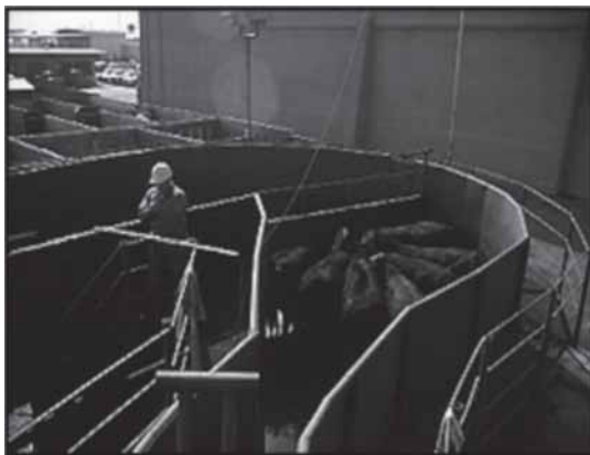
Fig. 2. Corral de encierro circular con paredes cerradas y puerta giratoria sólida. Una persona puede operar la puerta desde afuera del corral. Se deben instalar pequeñas puertas de escape para los trabajadores. El corral de encierro debe terminar en un embudo a la entrada de la manga, con una pared recta y la otra en ángulo de 30°. Los animales tenderán a atascarse si ambos lados están en ángulo respecto de las paredes de la manga (www.grandin.com).
